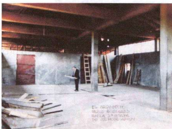
Remodelación del ex matadero
